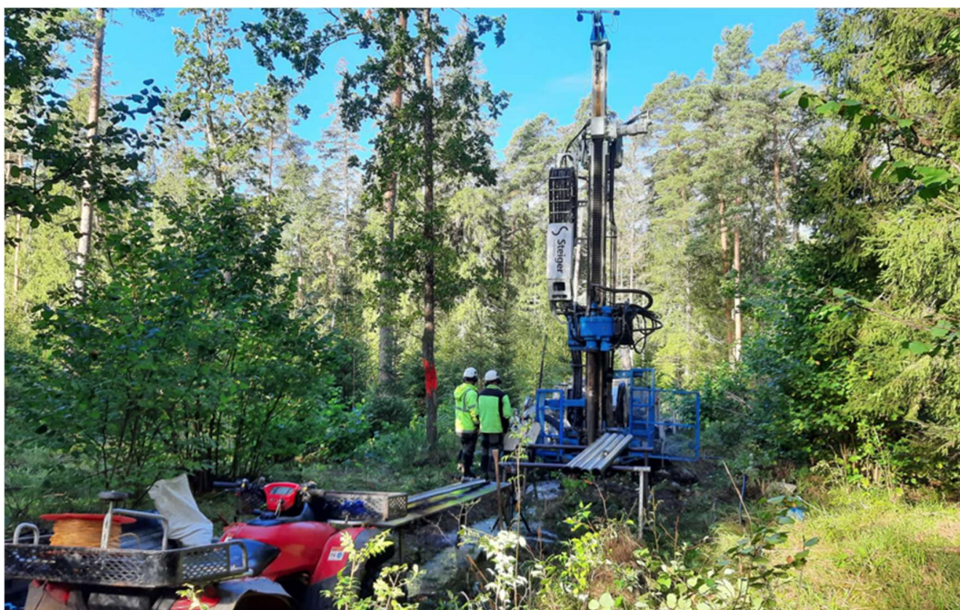
Foto 4.1. Puuraugu PA-5/25 rajamine Põlli III uuringuruumis. (Foto: S. Siir, 25.09.2025).
